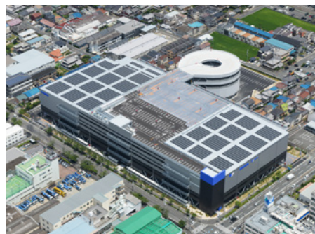
2021年8月稼働の100件目の施設「SGリアルティ東大阪」。860kWの発電を行い、施設内に電力を供給しています。
